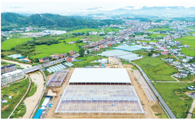
建设中的食用菌(褐菇)生产基地一期项目。熊凤霞 摄
