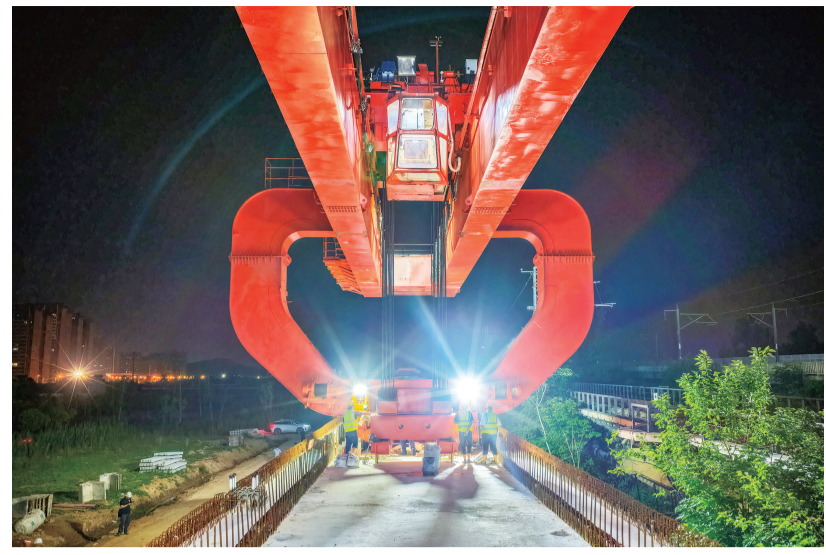
6月6日4时30分，在蚌埠市龙子湖区长淮卫镇淮宿蚌城际铁路建设现场，最后一根箱梁精准架设在蚌埠南站特大桥48号墩至49号墩间，标志着淮宿蚌城际铁路全线架梁任务顺利完成，为后续无砟轨道、牵引供电等工程施工奠定了坚实的基础。雷昊 摄
