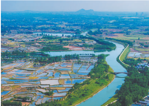
佛子岭水库为下游提供灌溉水源(蒋常虹供图)
