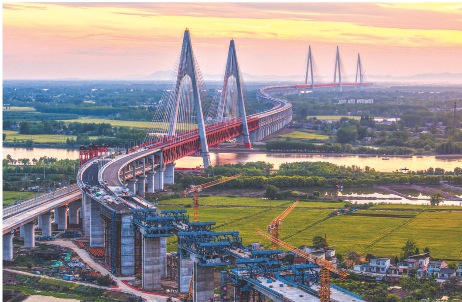
5月1日,位于马鞍山市当涂县的巢马高铁长江公铁大桥正加紧建设,全力推进工程进度。项目建成运营后,对进一步完善区域高速铁路网布局,促进长三角一体化高质量发展具有重要意义。 王文生 摄
