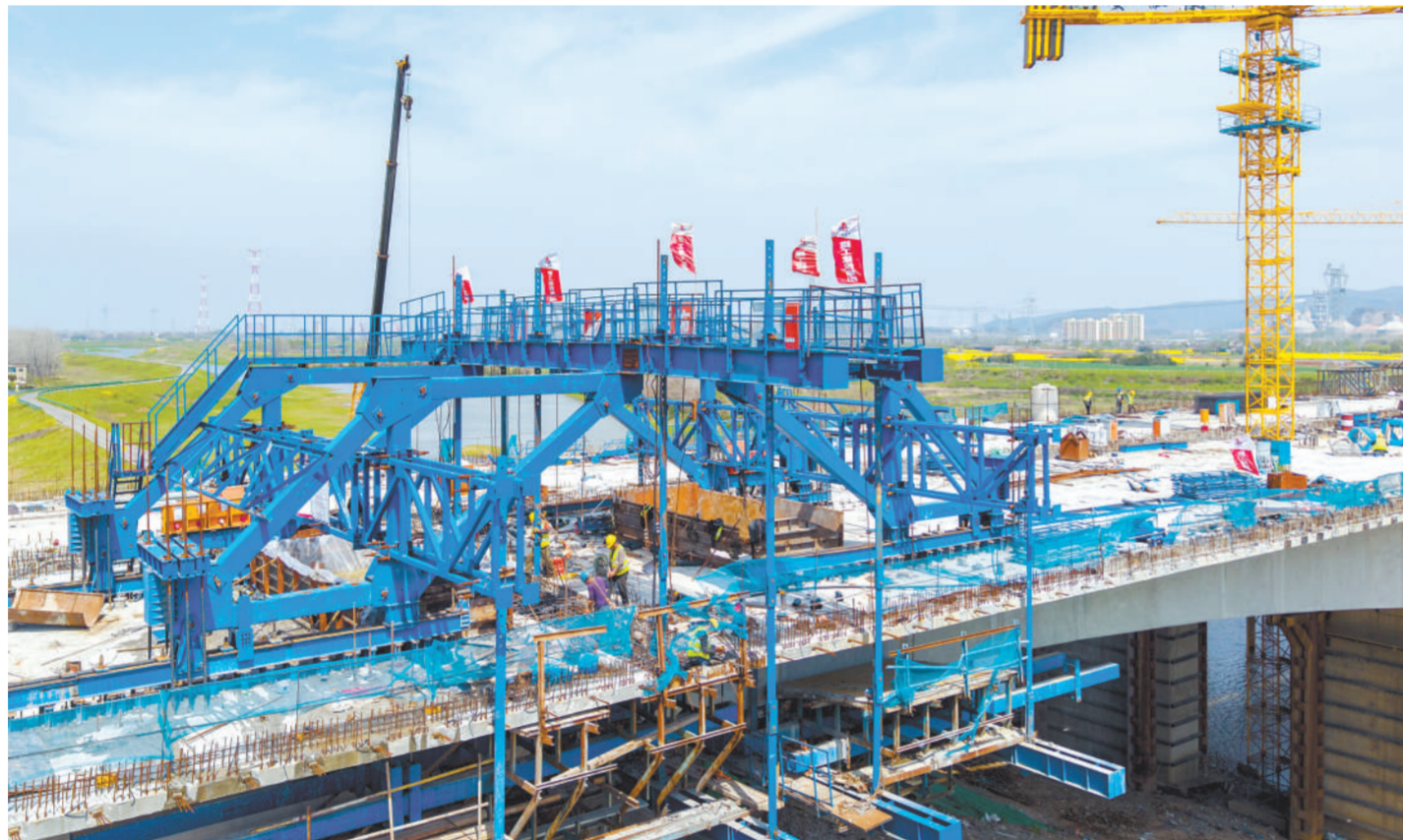
3月28日,在芜湖市繁昌区荻港镇,G236黄浦河特大桥施工现场繁忙有序,大桥建设按计划稳步推进。本报通讯员 刘伯顺 摄
