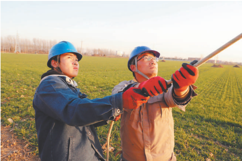
1月12日,在亳州市涡阳县楚店镇孙火楼村,电力施工人员正在进行10千伏农村电网升级改造工程建设。新年伊始,国网涡阳县供电公司一线建设人员在确保安全和质量的前提下,有序开展电网工程建设,提升电网供电可靠性,确保春节期间电力供应安全。 姜延旭 摄
