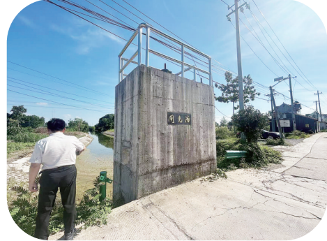
图为 2022 年修建完成的潘克闸。赵明 束金丽 摄
