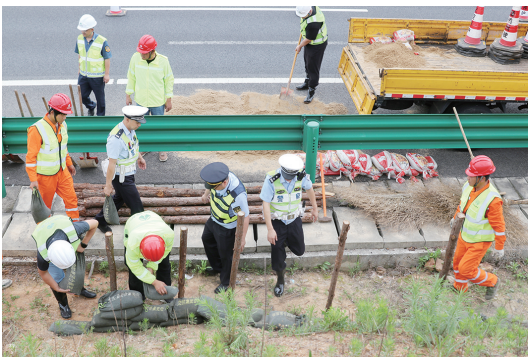
6月19日,在合芜高速公路马龟山路段,芜湖市公安局交警支队高速三大队会同高速公路路政、交通、养护等“一路多方”,开展汛期高边坡垮塌事故应急救援演练活动。图为模拟因暴雨引发山体塌方现场,民警和“一路多方”工作人员通过搬运沙袋固定边坡等方式,及时排除事故隐患。
