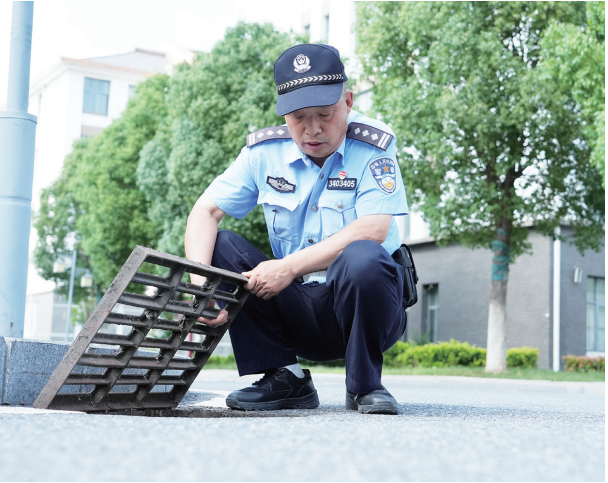
李振远检查雨水管道。
