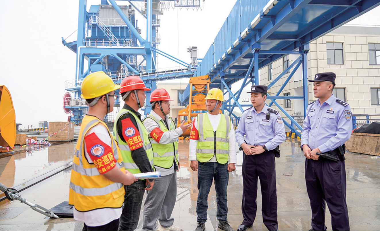
4月17日,宿松县公安局复兴派出所民警来到安庆港宿松县港区公用码头施工工地,指导施工单位治安巡防员做好企业内部安全管理工作,联手打造“平安工地”。
