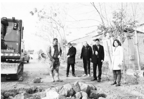
11月30日上午,砀山县交通运输局一行4人,先后深入G237与杨薛路交叉口、程关路与官关路交叉口、官关路李楼客厂与李路路葛集段等排查发现的县乡农村公路隐患点,现场督导隐患点整改施工进度情况。
