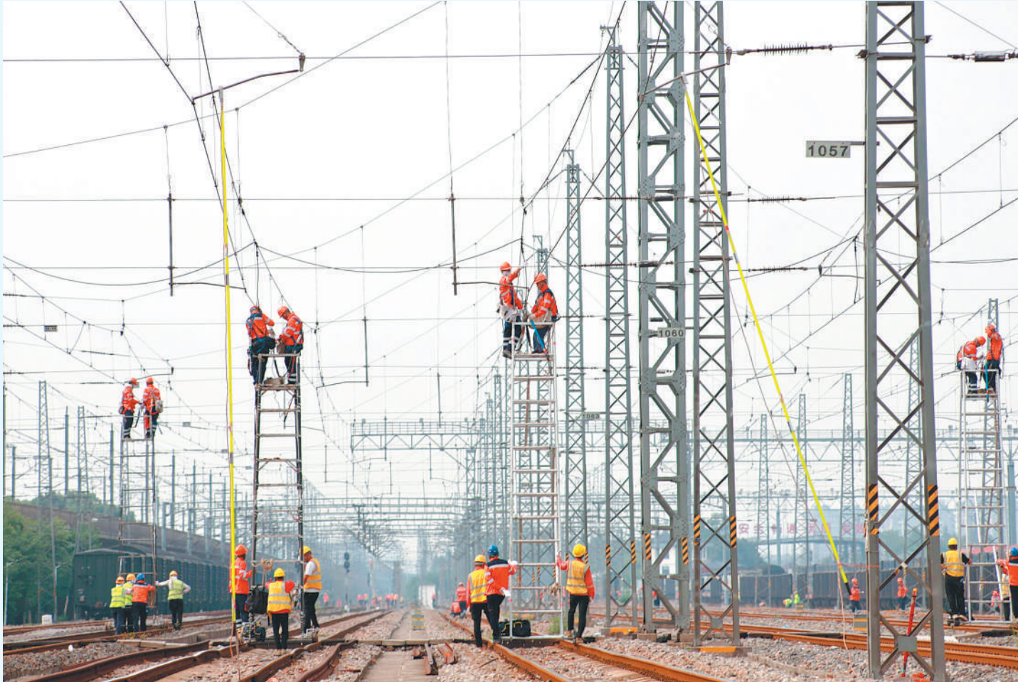
9月15日,宁芜铁路芜湖枢纽“大天窗”集中修施工现场,维修人员对接触网进行精细化检修。本次施工分批次对芜湖东一场、五场重点股道接触网设备集中整治,覆盖芜湖枢纽三大供电单元,全面消除设备安全隐患,为即将到来的中秋、国庆假期铁路安全运输保驾护航。 本报通讯员 杜希昊 摄
