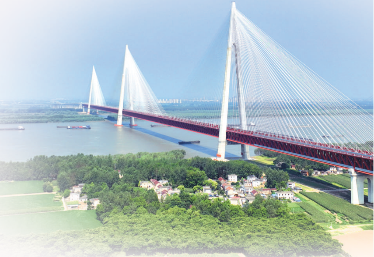
▲ 巢马高铁马鞍山长江公铁大桥。 储灿林 摄
