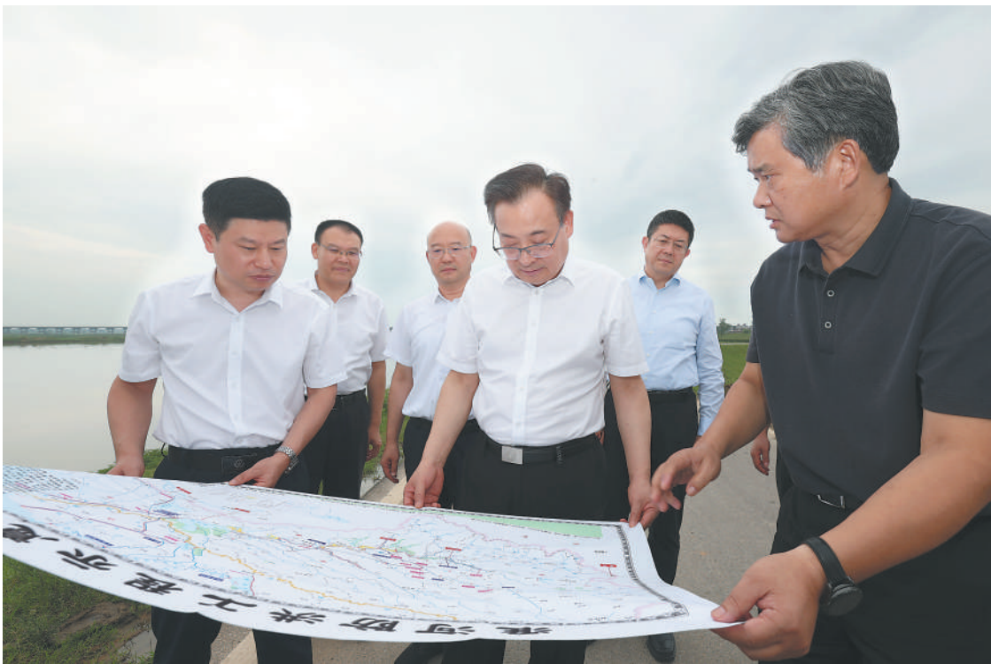
八月十五日,省委书记梁言顺在阜阳市颍上县淮河大堤南照段,检查堤防维护、防汛准备等情况。
