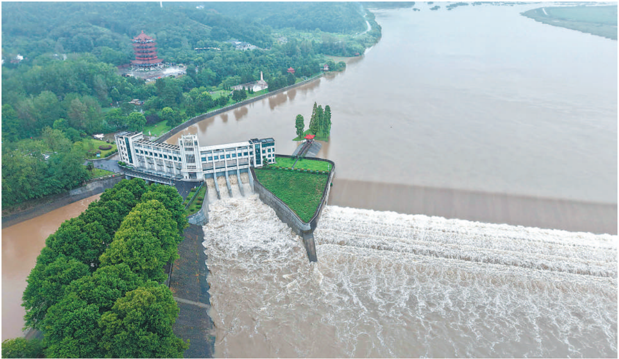
8月11日,位于六安市裕安区的淝河横排头渠道枢纽开闸泄洪。
