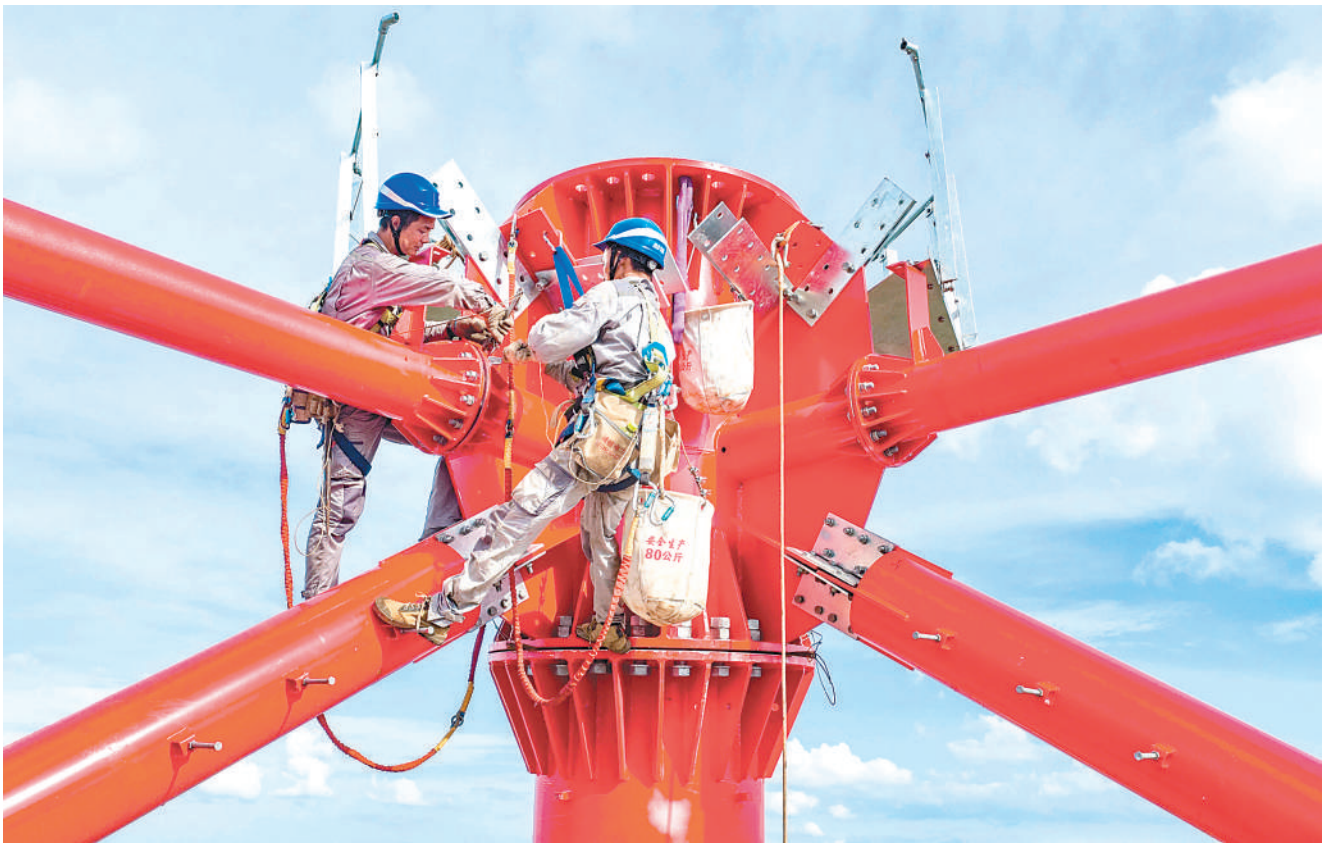
8月4日,马鞍山市湖北路过江通道项目,建设者在隧道内作业,为盾构始发做好准备。 本报记者 李博 摄
