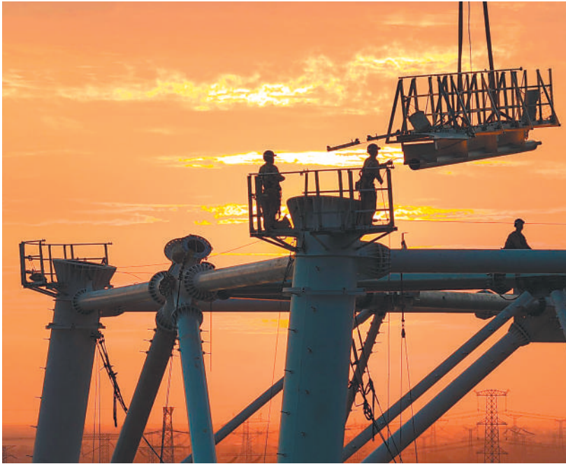
8月3日傍晚，芜湖市繁昌区荻港镇，国网安徽电力施工人员在高空组立特高压长江大跨越输电塔，稳步推进西电东送重点工程建设。 本报通讯员 肖本祥 摄
