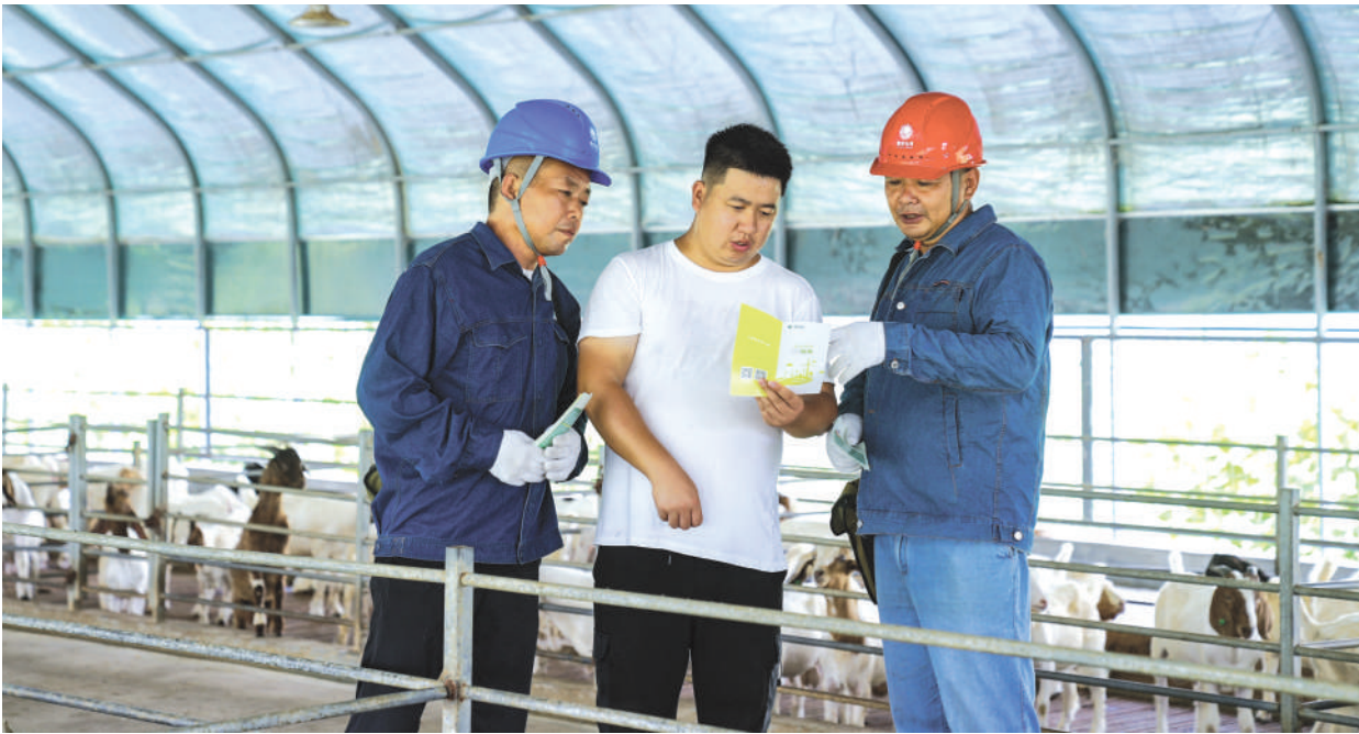
近日,萧县伏羊文化节开幕,国网萧县供电公司精准优化保供措施,调派高压发电车全程驻场,实现“主供、备用、移动电源”三级防护,结合伏羊文化产业全链条用电需求,巡检白山羊养殖基地、餐饮商户,助力特色产业稳产稳供。
