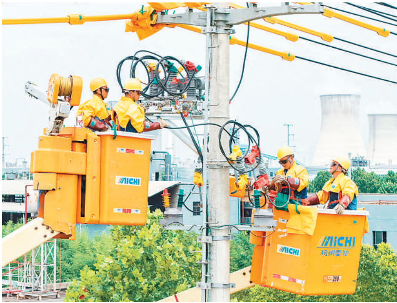
7月28日，滁州市炉桥镇，国网滁州供电公司带电作业人员在安装10千伏智能负荷开关，保障居民和企业夏季正常用电。
