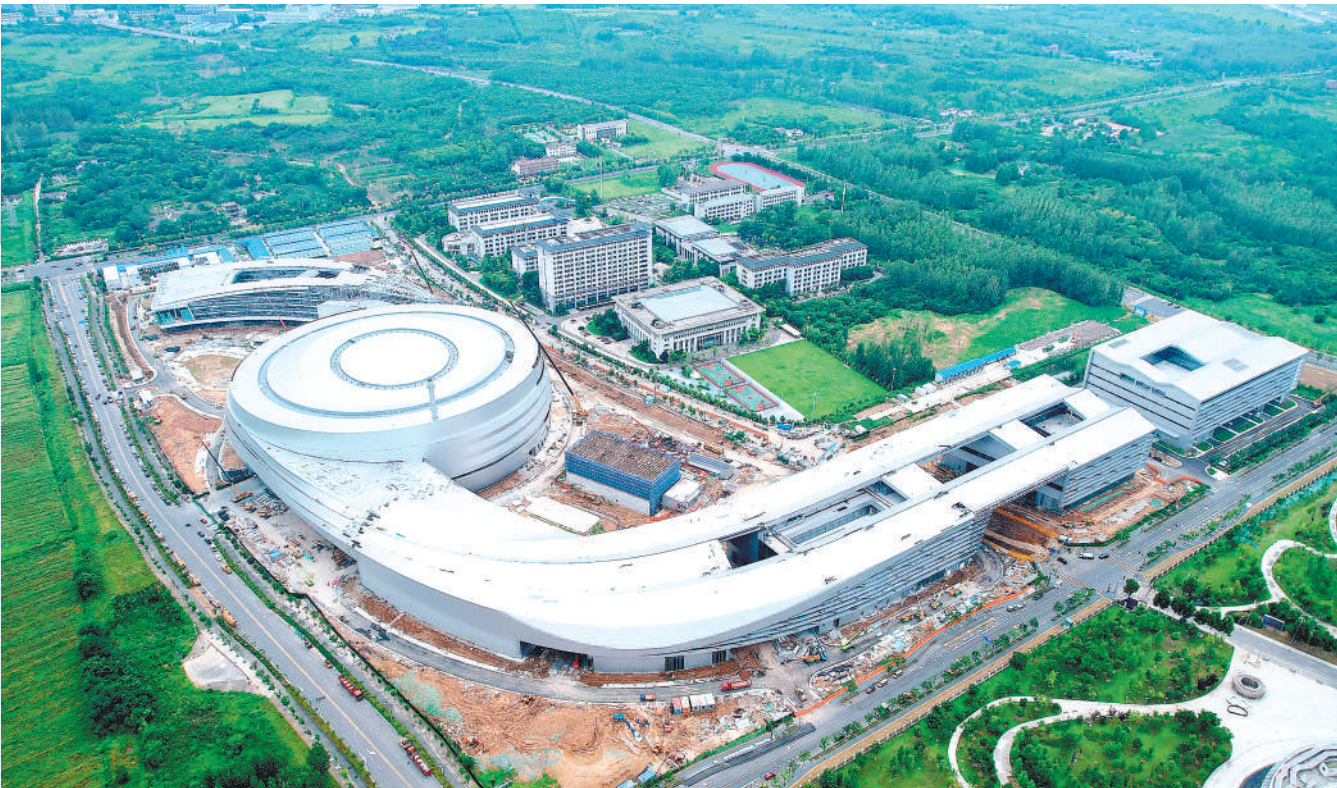
7月27日，航拍的位于合肥市庐阳区三十岗乡正在加紧建设中的紧凑型聚变能实验装置(BEST)。BEST装置作为全超导托卡马克核聚变实验装置(EAST)的后续项目，将在第一代EAST装置的基础上，首次演示聚变能发电，并有望率先建成世界首个紧凑型聚变能实验装置。 本报通讯员 葛传红 摄
