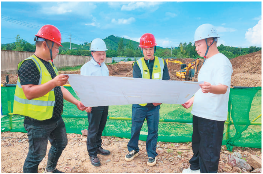
► 7月23日，杨广奇（左二）在广德黄金芽碾抹茶项目现场了解工程推进情况。
