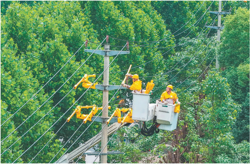
7月1日9时许,国网合肥供电公司在合肥市蜀山区大别山路与双塘南路交叉口,开展大规模集中带电作业,以“零感知”服务守护城市平稳供电。
