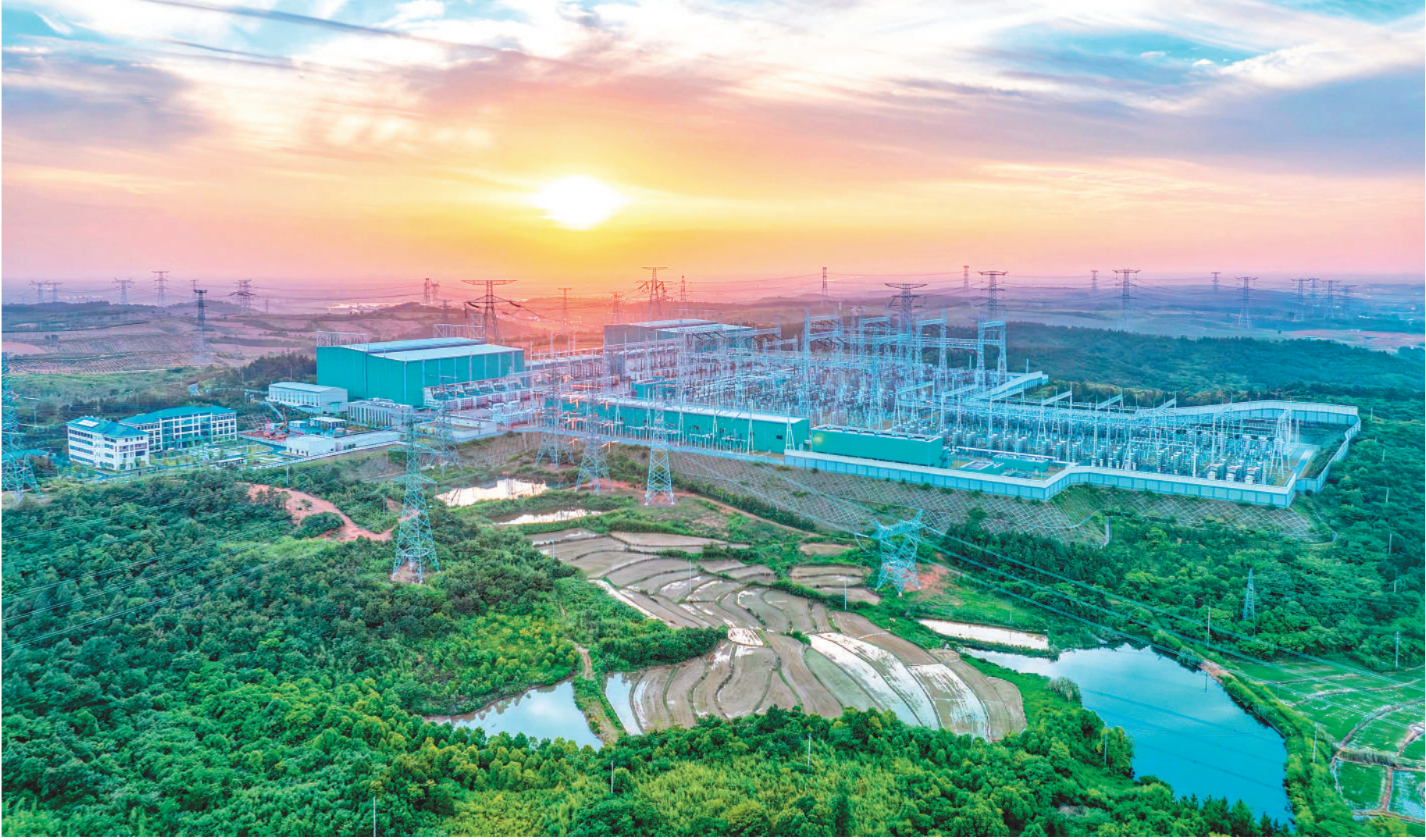
7月21日,位于宣城市的准东—皖南特高压±1100千伏古泉换流站累计落地电量突破4000亿千瓦时。该站为“西电东送”重要通道,为迎峰度夏期间长三角地区电力保供提供有力支撑。
