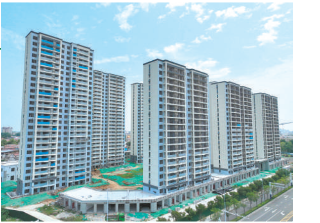
7月21日,蒙城县齐山路安置小区二期工程建设现场,工人正在进行外墙及相关配套工程施工。 本报通讯员 胡卫国 摄
