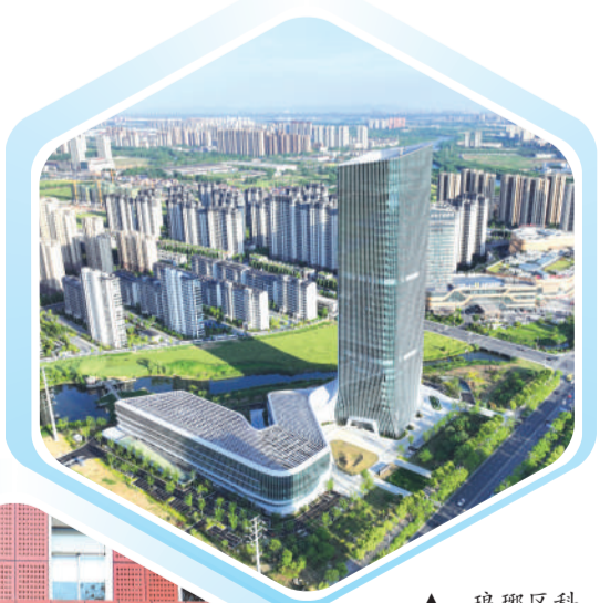
▲ 琅琊区科创中心大楼 杨毅 摄
