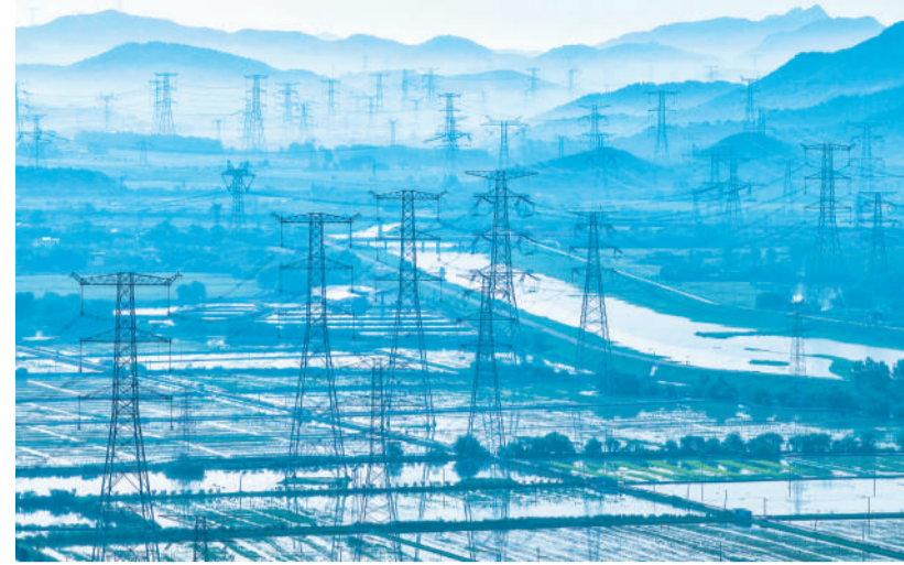
4月27日,芜湖市繁昌孙村镇境内“西电东送”特高压输电工程与晨雾、山峦、乡村田野等相映成景。吉泉±1100千伏等多条特高压输电工程通过繁昌孙村镇境内的特高压走廊,将中西部丰富电能高效输送至长三角等地区。 本报通讯员 魏君元 摄
