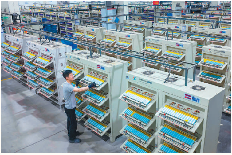
4月10日,安徽巡鹰新能源集团有限公司分容车间,工人在对拆解回收的电池进行容量分析测试。
