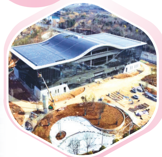
▲ 桐城东部新城院士科创园项目施工现场。
