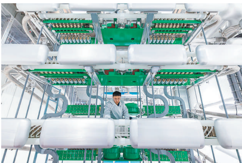
3月18日，在庐江县，陕北—安徽±800千伏特高压直流输电工程(简称“陕北入皖”工程)合州换流站，国网安徽超高压公司员工在低电压厅开展直流设备验收。 本报通讯员 徐乐阳 摄
