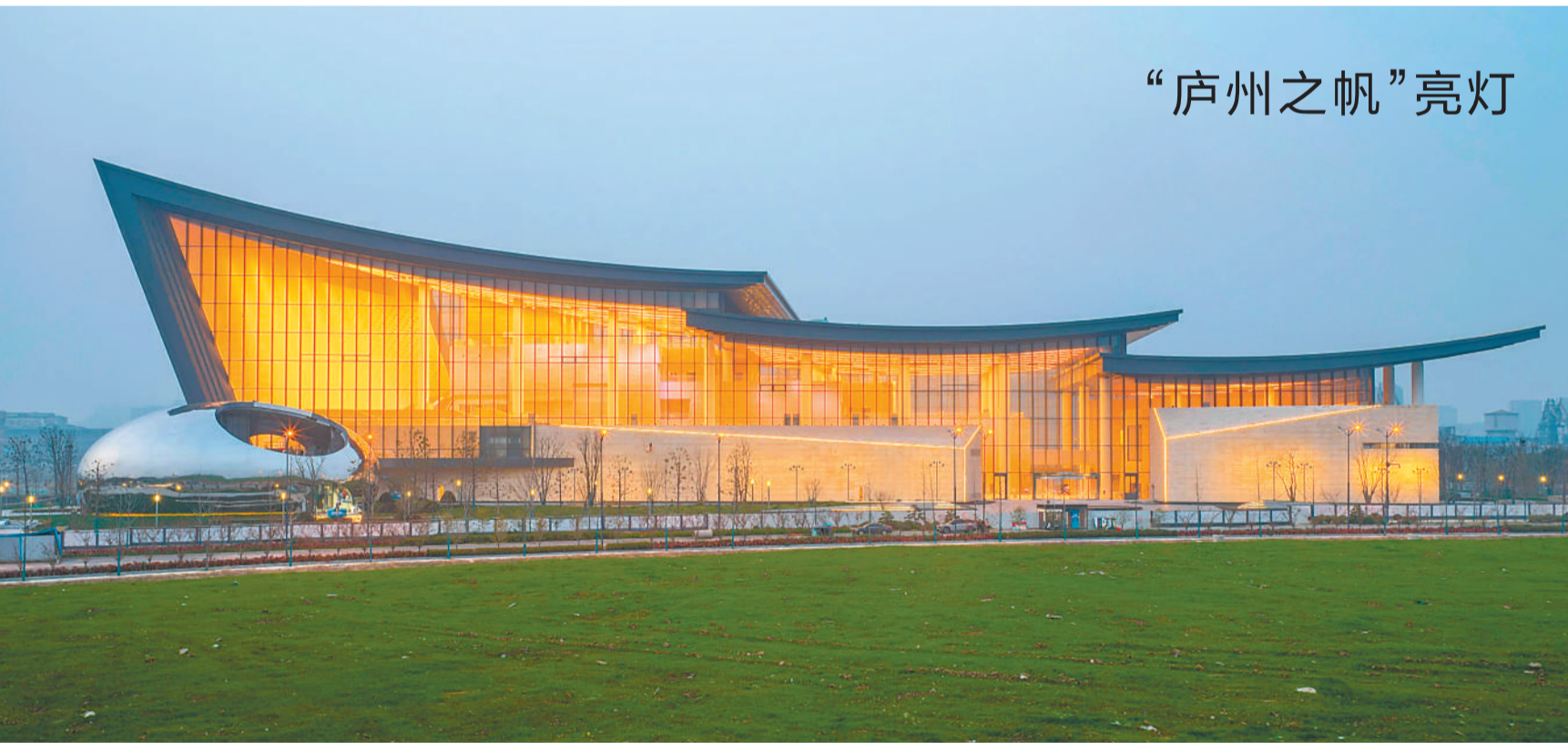
3月19日晚，合肥市博物馆——“庐州之帆”正式亮灯。据悉，位于合肥市瑶海区南淝河畔的“庐州之帆”是该市首个综合性博物馆，总建筑面积5.48万平方米，外形取“历史之书、时代之舟、未来之帆”的丰富意象。该馆建成后将成为展示省城历史文化、提升城市文化形象的重要场馆，为市民提供高规格的文化服务。
