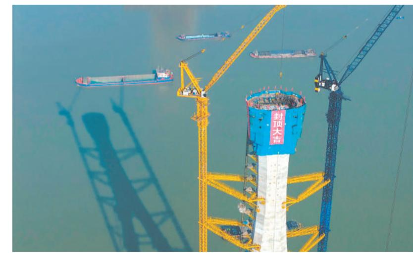
1月15日,在长江池州段,最后一方混凝土被稳稳泵送至272.7米的高空并顺利入模。这标志着池州长江公铁大桥4号主塔封顶,项目建设取得阶段性重大进展。该桥是我省第六座跨长江的公铁两用大桥,连接池州市贵池区与铜陵市枞阳县,全长约3.1公里,其中主桥长1768米。
