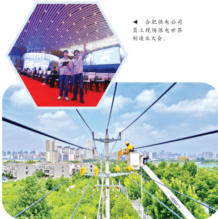
合肥供电公司员工进行不停电作业检修。
