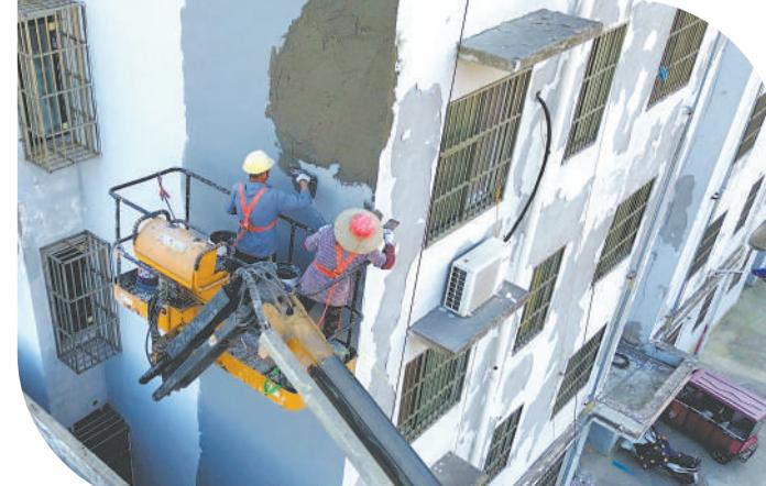
近日，宿州市埇桥区汴河街道塘河小区，工人正在维修损毁的居民楼外墙。连日来，汴河街道物业办坚持以居民需求为导向，着力解决居民关注的热点问题，全面排查居民小区安全隐患，对发现的墙面脱落等问题及时组织施工维修。
