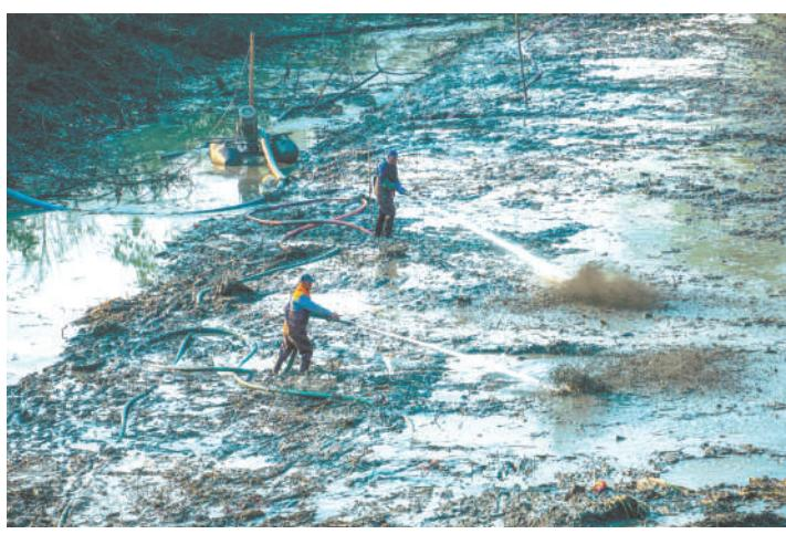
11月14日，在芜湖市繁昌区荻港镇东大河清淤疏浚工程施工工地上，工人在清淤作业。连日来，当地利用冬季枯水期大力开展兴修水利工作，推进防洪、排涝、灌溉等水利基础设施建设。
