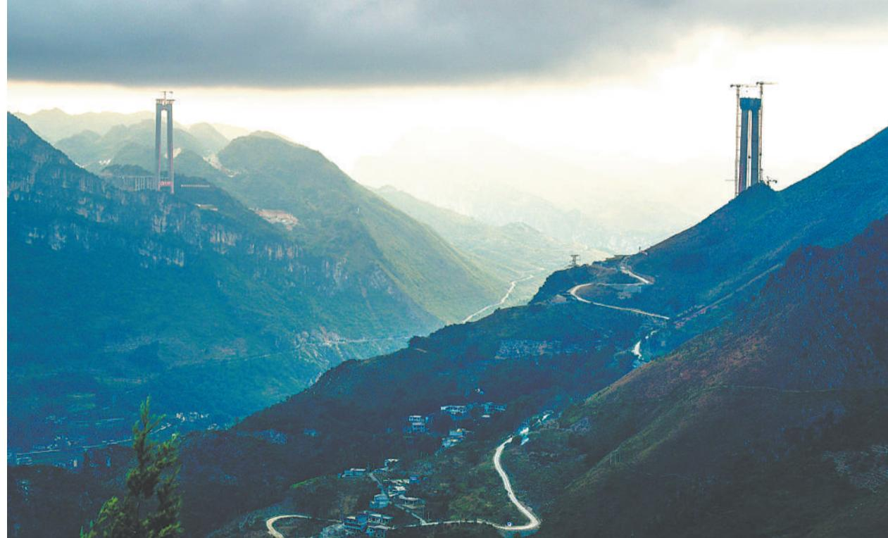
这是11月7日拍摄的贵州六安高速花江峡谷大桥两岸主塔。目前，由贵州桥梁集团和贵州公路集团共同承建的六安高速花江峡谷大桥两岸主塔顺利封顶，大桥关键性施工节点获突破性进展。花江峡谷大桥是贵州六安高速公路的控制性工程，建于被称为“地球裂缝”的花江大峡谷之上，全长2890米，主跨1420米，主桥桥面与谷底的北盘江水面垂直高度达625米。
