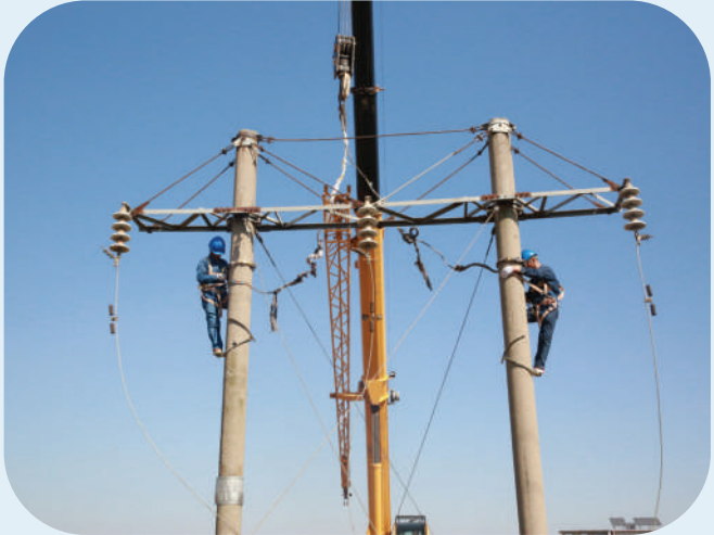
近日，新建的35千伏十八里铺变T接联络35千伏线路改造工程建成投运，国网颍上县供电公司电力员工拆除该县35千伏原三管3392线路棚支线杆塔，消除安全隐患，还田于民，为农业秋种排除障碍。
