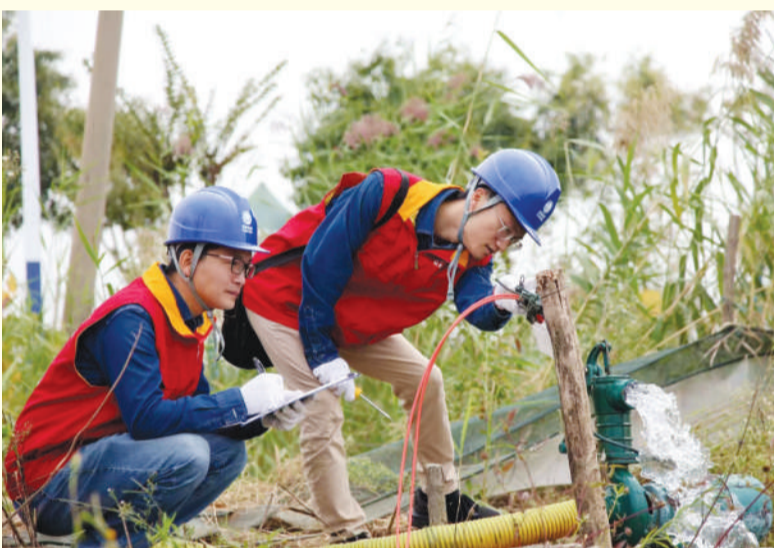
近日,国网旌德县供电公司带电作业班在该县10kV华坦114线三溪路分线012号杆加装智能开关及跌落式熔断器,在客户零感知的情况下完成线路升级改造,全力备战冬季用电高峰。肖悦摄
