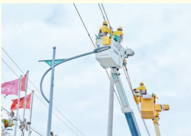
日前,国网五河县供电公司皖美共产党员服务队队员来到该县沱湖乡圩后村,开展“小、零、散”水产养殖隐患排查安全服务专项行动,宣传安全用电知识,协助整改隐患,为当地经济发展提供电力保障。陈涛摄
