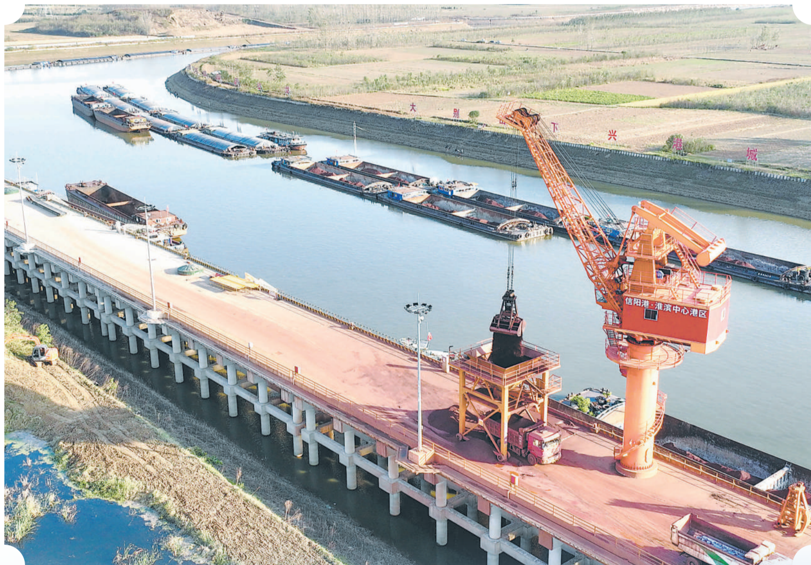
江淮运河开通后，大大缩短皖豫两省运输的时间和距离，提升货运效率，有效降低企业物流成本。图为河南淮滨港。
