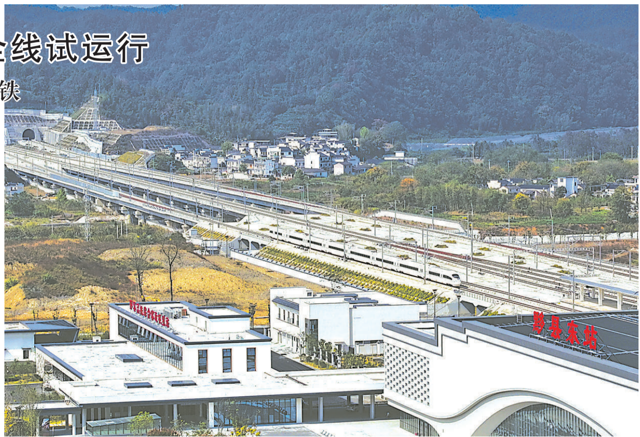
10月26日,试运行列车通过黟县东站。
