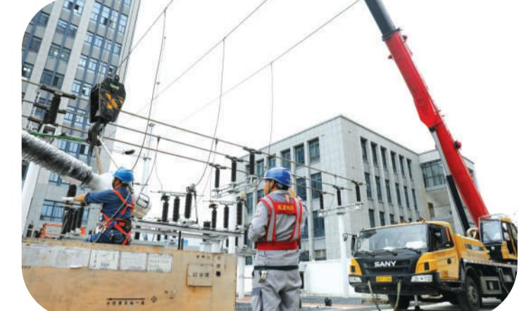
近日,国网长丰县供电公司检修人员在110千伏双凤变电站开展吊装更换电流互感器作业。 刘兵 摄
