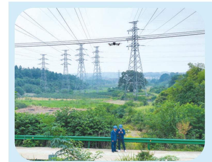
近日,国网望江县供电公司输电巡检班无人机巡检小组开展110千伏武坦576线单电源运行保电巡视工作。巡检小组借助无人机高清晰摄像头,对杆塔的金具、导线、绝缘子等全方位拍摄;利用无人机进行红外检查,搜寻地面人员看不到的线路隐患,多角度拍摄线路节影像,做到隐患早发现、早处理,确保电力线路安全可靠,助力秋检工作提质增效。
