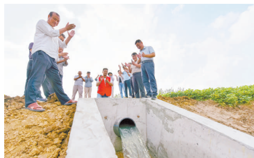
9月6日,肥东县八斗镇新社区吴巷组,从滁河干渠引取的长江水在灌溉农田。近年来,该县大力推进农田水利设施建设,增强水利设施防汛抗旱能力。 本报通讯员 高德升 摄
