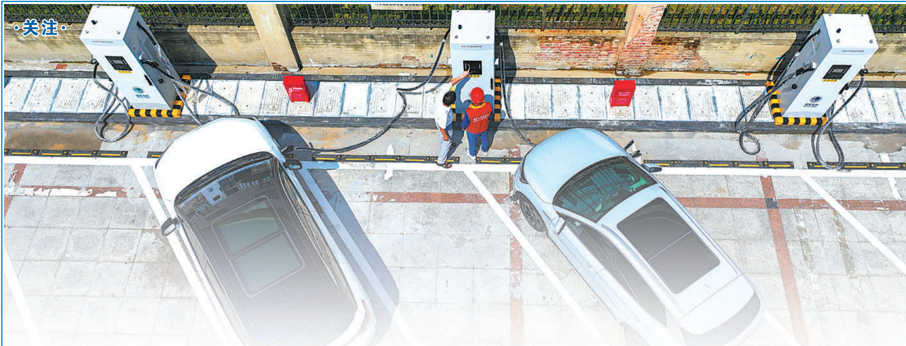
全省新能源汽车产业集群建设推进大会要求,充分发挥省充换电基础设施监管服务平台和充换电公司作用,大力推进“互联网+充换电基础设施”——
