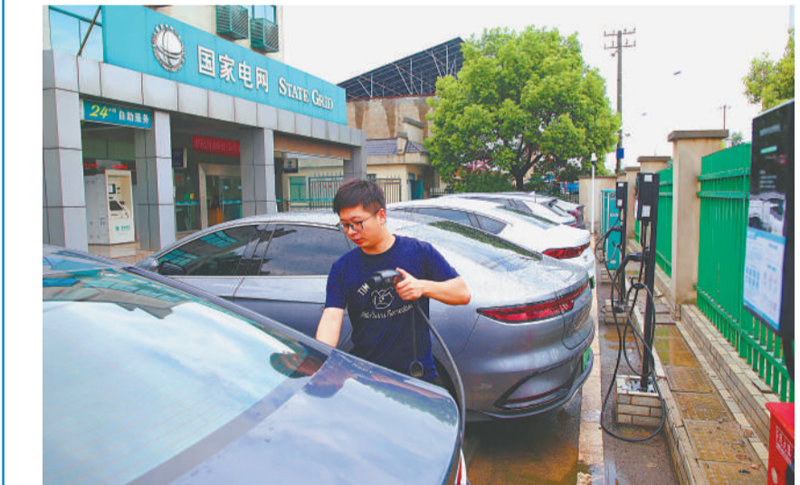
日前,在位于合肥市长丰县吴山镇的国网合肥供电公司吴山供电所,当地居民正在使用新一代有序充电桩为爱车“续航”。
