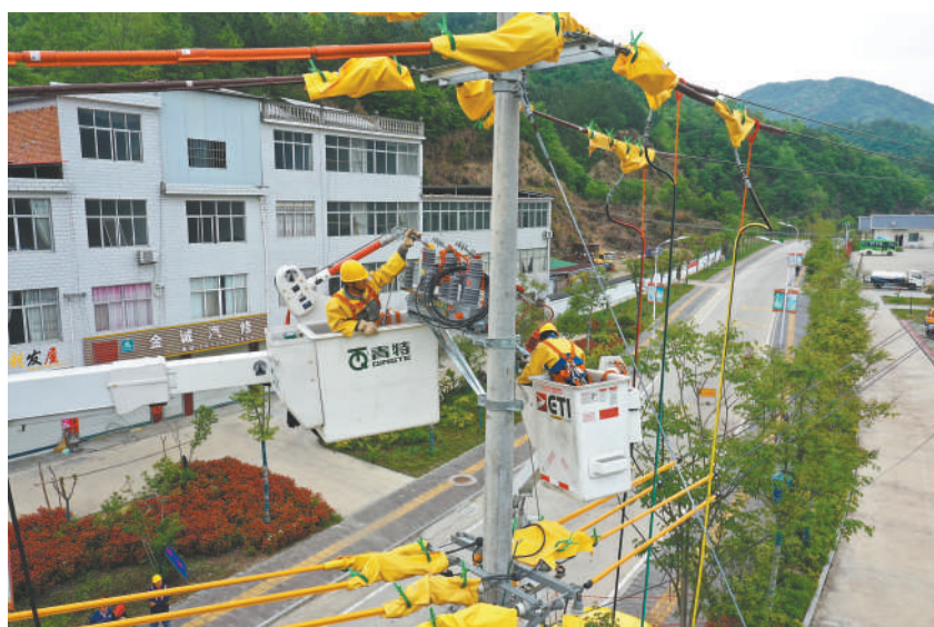
日前,国网全寨县供电公司不停电作业班在开展带电更换真空开关工作。此次作业共计减少停电36时户,输送电能564kWh,保障了该区域茶企茶农正常用电。 本报记者 许昊 本报通讯员 詹杨 摄
