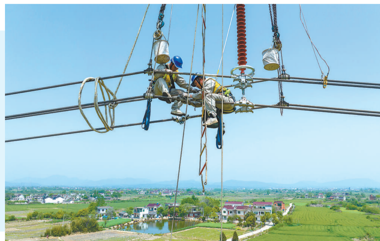
4月17日,在无为市石涧镇,国网芜湖供电公司工作人员对“西电东送”能源大动脉±500千伏龙政线开展更换绝缘子作业。该线路是三峡电站送电华东的第一条直流输电线路,输电容量300万千瓦,安徽段全长约370公里。连日来,国网芜湖供电公司组织人员对±500千伏龙政线开展检修,切实保障“西电东送”能源大动脉安全稳定运行。
