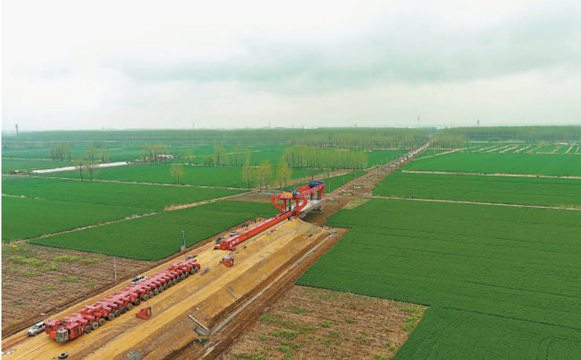
近日,随着一捆长32.6米、重800吨的箱梁缓缓落在怀洪新河特大桥458号-459号桥墩(台)上,合新铁路项目线上作业全面展开。合新高铁连接合肥市与江苏省新沂市,全长超323公里,设计速度350公里/小时。 本报通讯员 李向前 摄
