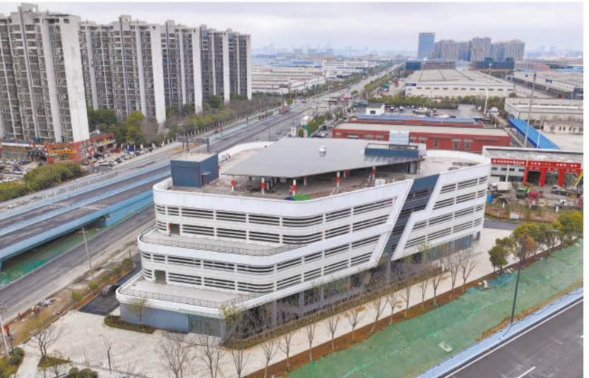
3月17日，位于合肥经开区的新能源汽车充电设施综合体工程主体完工，成为该市首个充电综合体屋面光伏建筑一体化(BIPV)并网发电项目。该工程包含地下1层、地上5层，配套停车楼，共185个停车位均配备快速充电桩，建成后将以“充电+商业”模式运营。 本报记者 程兆 摄
