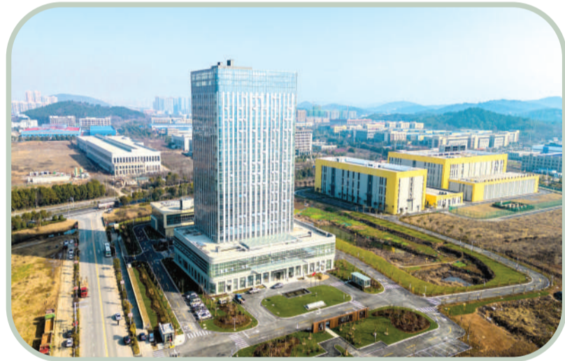
马鞍山智能装备及大数据产业园项目。
