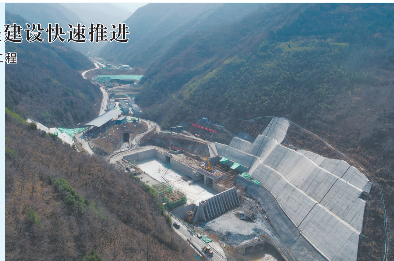
这是2月24日拍摄的位于西安市周至县的陕西引汉济渭工程黄池沟配水枢纽施工现场。 新华社记者 张博文 摄
