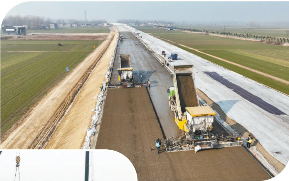
▲ 1月5日，在亳州市涡阳县标里镇毫蒙（亳州到蒙城）高速公路一期工程施工现场，施工人员在摊铺沥青路面。
