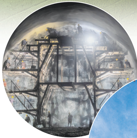
昌景黄铁路云头山隧道掌子面开挖作业。郎成涛 摄
