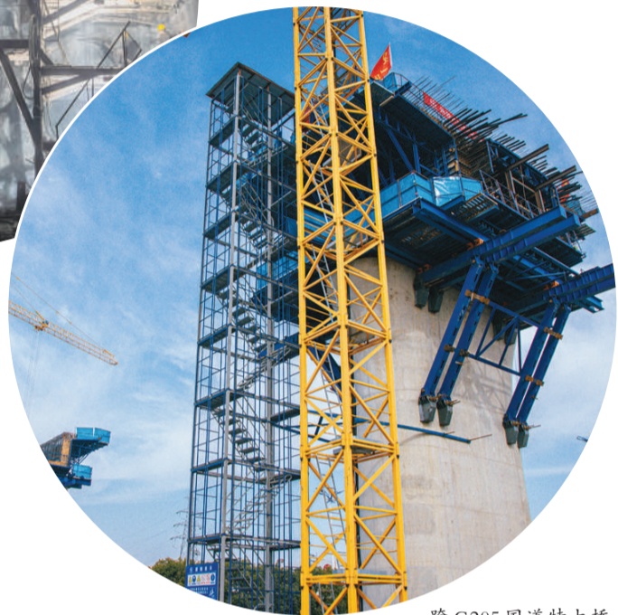
跨G205国道特大桥。
