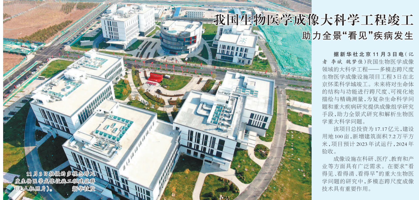
11月3日拍摄的多数塔地度生物医学成像设施工程建筑群(无人机照片)。新华社发
